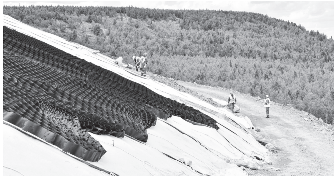
Процесс укладки бентонитовых матов
