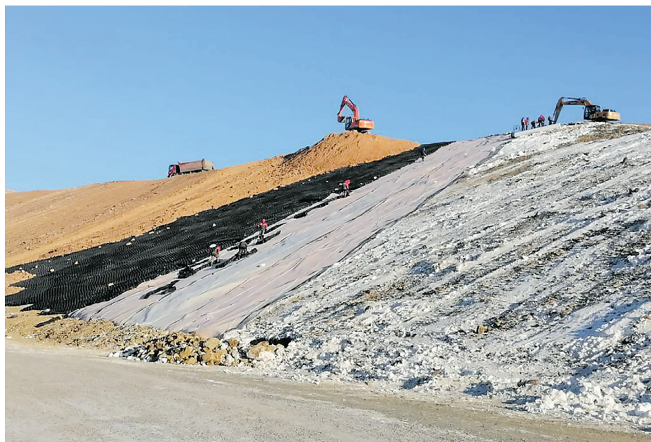
Укладка бентонитовых матов
