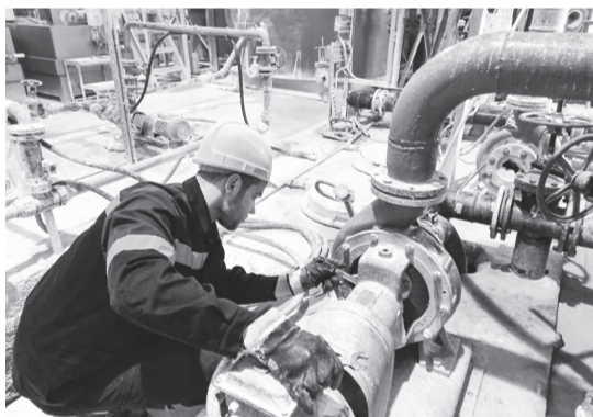
Подготовка очистных сооружений Тарньерского месторождения к паводку
