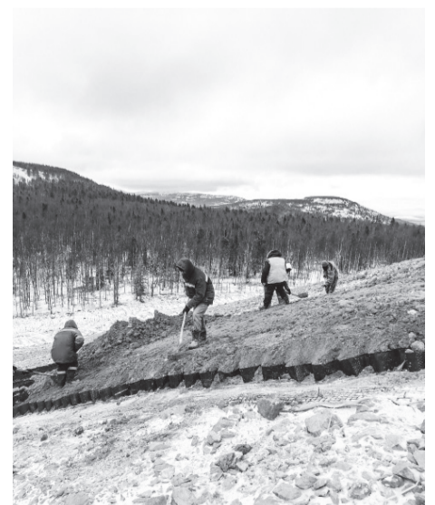
Укладка бентонитовых матов
