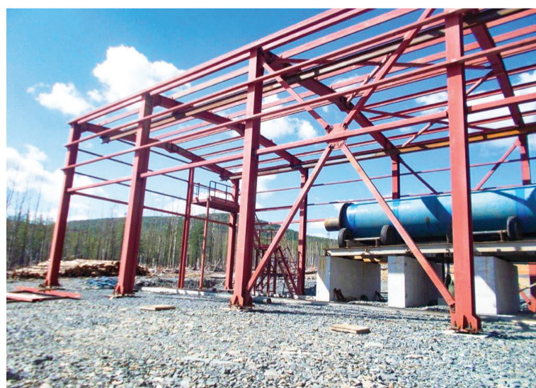
Выполнен монтаж каркаса здания и цементационных барабанов на участке осаждения меди
