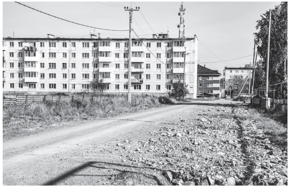
Ремонт улицы 50 лет Комсомола
