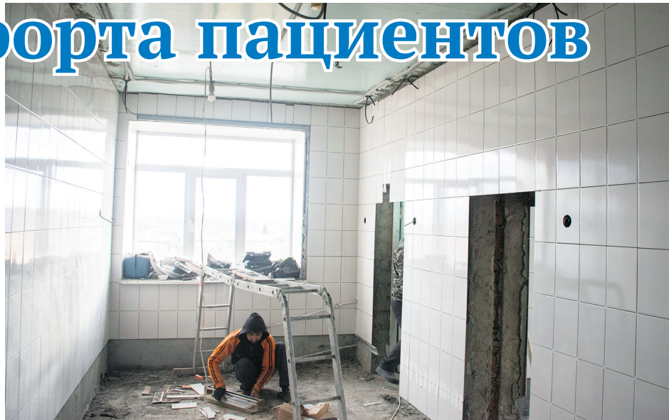
Идет ремонт операционного блока
